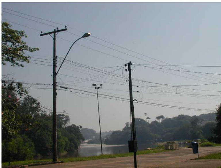
**Figura 22:** Poluição visual causada pela fiação aérea aparente na região do calçadão da Rua do Porto, necessitando de transformação para rede compacta ou subterrânea (mais adequadas ao aspecto paisagístico do local).
